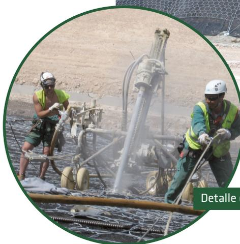
Detalle de la instalación de la red de anillos
