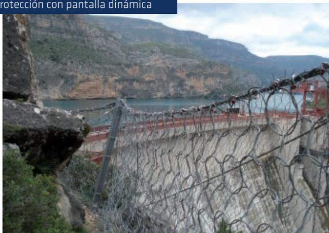
Estabilización con pantalla dinámica (red de anillos).
